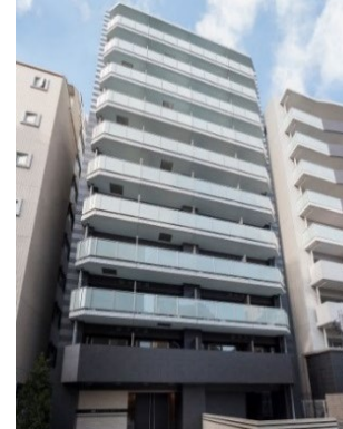
マンション施工事例
