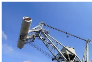
ドローンによる高所外観点検
