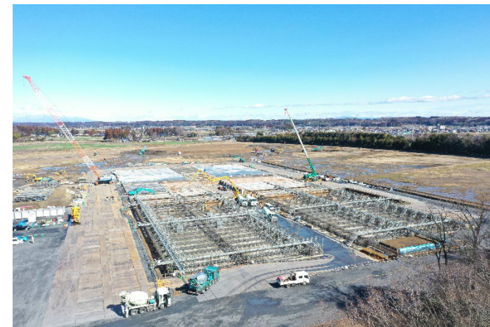
2024年2月の建築状況 (栃木県高根沢町花岡)
