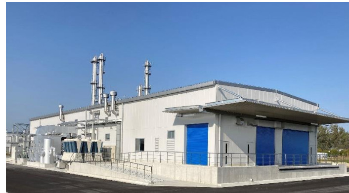
淡路工場 第2屋内充填所 完成(2024.3月)
