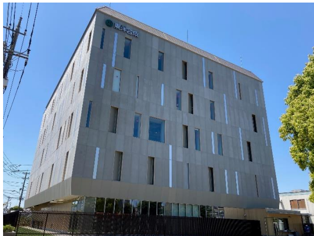
千葉工場 感光材開発分析棟 完成 2024.5月
