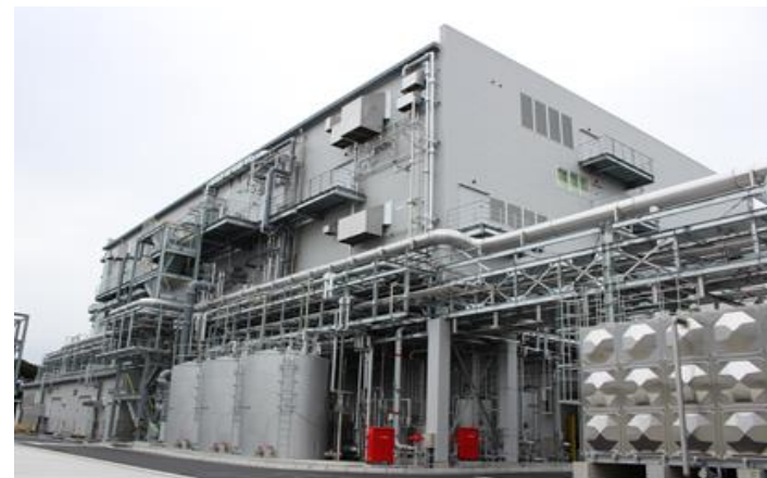
千葉工場 第4感光材工場 先端品生産ライン 2024.8月 完成予定
