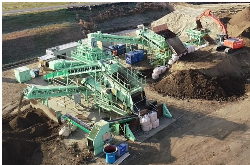
回転式破碎混合工法（通称：ツイスター®）
