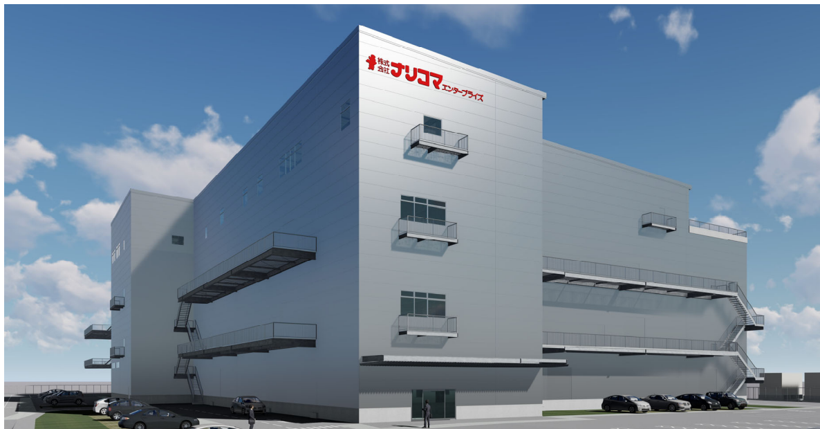
(仮称) 株式会社ナリコマフード神戸工場建設工事の内建築工事（兵庫県）
