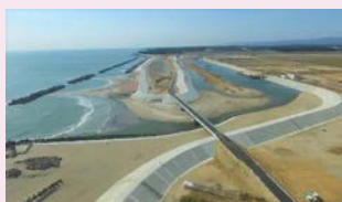
河川堤防工事
