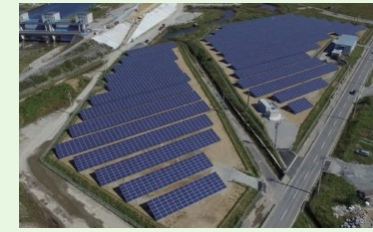
津軽石太陽光発電所 (岩手県宮古市) (2) ● 発電出力1,607kw (パネル設置枚数6,300枚) ● 太陽光発電システム (株) 日立製作所 ● 定格出力 1,320kw ● 2015年9月から売電開始
