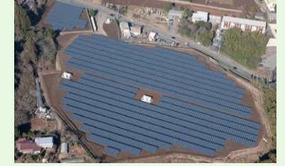
アンビックスソーラー富里 (千葉県富里市) ● 発電出力2,675kw (パネル設置枚数10,920枚) ● 太陽光発電システム (株) 日立システムズ ● 定格出力1,996kw ● 2014年1月から売電開始
