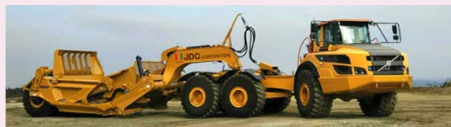
重機土工（国土開発工業）
