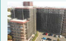
大規模修繕工事
