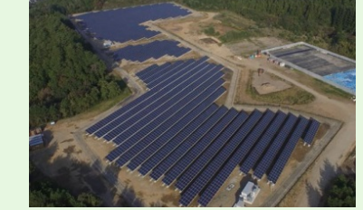
アンビックスソーラー会津坂下 (福島県河沼郡会津坂下町) ● 発電出力2,693kw (パネル設置枚数10,164枚) ● 太陽光発電システム (株) 日立システムズ ● 定格出力1,996kw ● 2016年10月から売電開始
