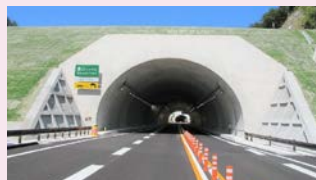
トンネル建設工事
