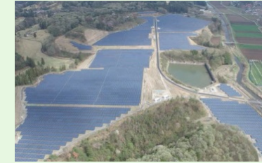
宇都宮北太陽光発電所 (栃木県宇都宮市) (1) ● 発電出力18,837kw (パネル設置枚数71,085枚) ● 太陽光発電システム (株) 日立製作所 ● 定格出力13,860kw ● 2017年4月から売電開始
