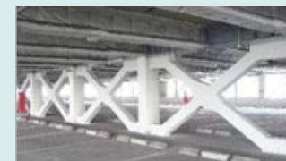
耐震補強（コクドビルエース）
