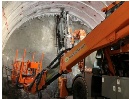
▲独自技術の深化により、施工の省力化と安全・品質の高度化を推進
