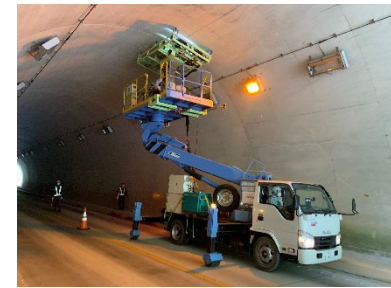
トンネル点検システムによる画像撮影と打音検査
