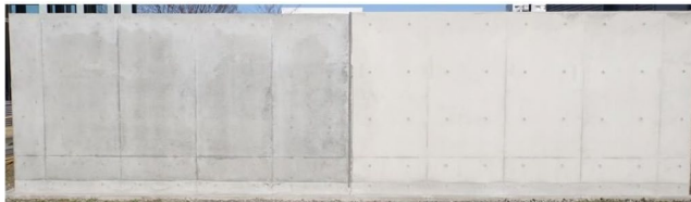
構築した壁部材の出来栄
