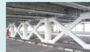
耐震補強（コクドビルエース）
