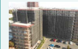
大規模修繕工事
