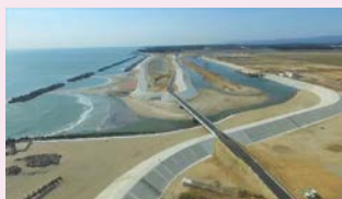
河川堤防工事
