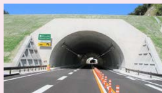
トンネル建設工事
